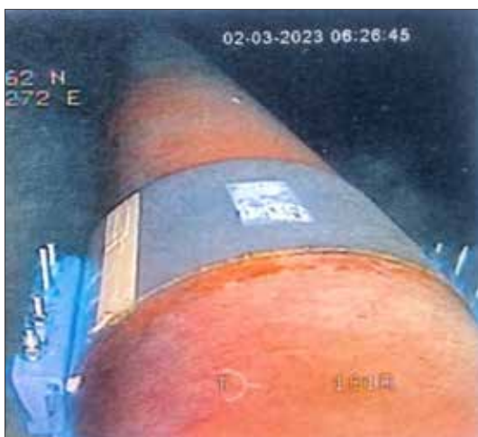
1. Condotta-sublacuale posata sul fondo 2. Clampa messa in posa sul collettore 3. Drafinsub. La Clampe utilizzate per incamiciare le condotte vaiolate dalle bioconcrezioni. Credist Acque Bresciane Credits ph: Drafinsub tramite editoriale GardaPost 4. Una bioncrezione
