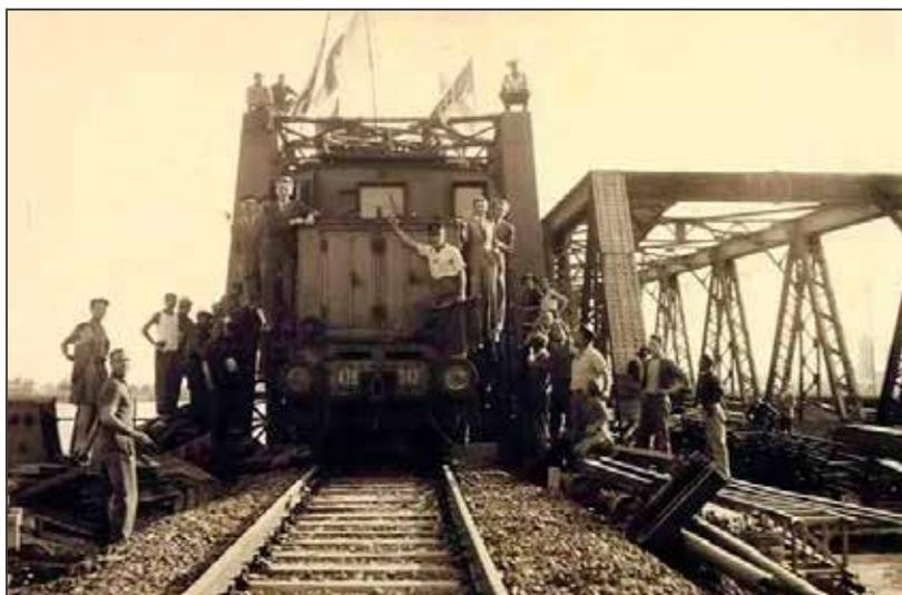
**Ripristino del ponte ferroviario - Nel 1949 furono completati i lavori di ricostruzione del ponte ferroviario sul Po con il contemporaneo ripristino della linea aerea. Il primo locomotore ad attraversare il ponte fu l'E 428 042, scortato da operai e tecnici. L'uomo in piedi sul frontale con la bandiera in mano e la camicia bianca era mio padre Roberto.**
